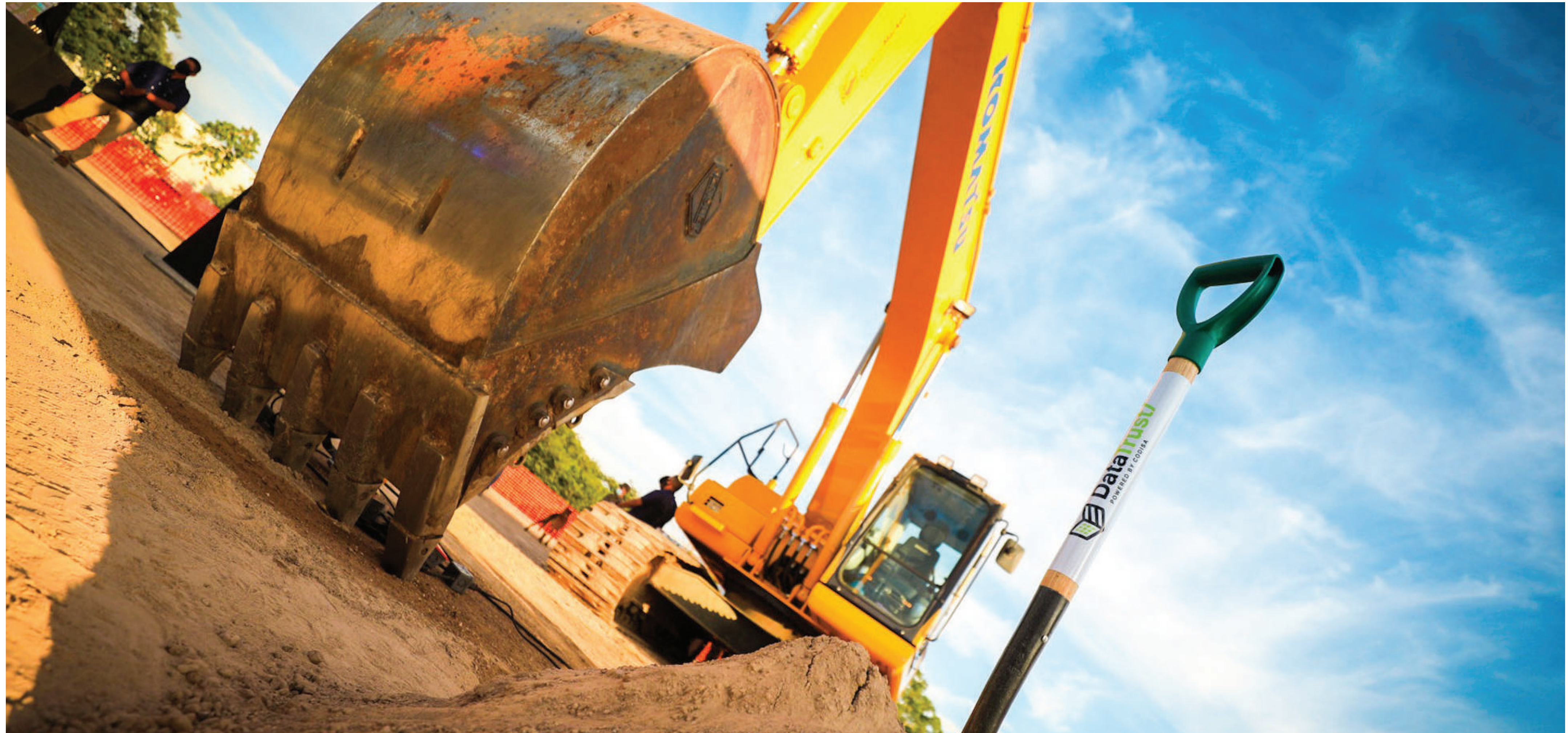
EVENTO COLOCACIÓN DE PRIMERA PIEDRA
